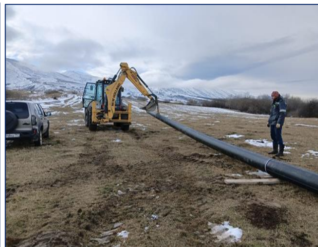
Строительство группового водовода в Казбековском районе 2023-2024
