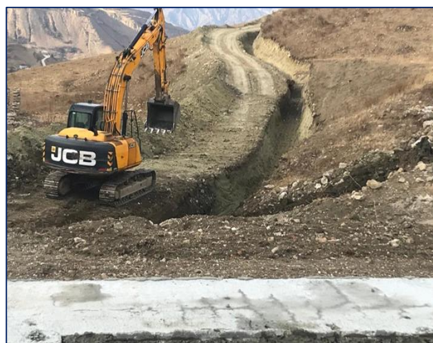
Водоснабжение с. Карата Ахвахского района 2023-2024
