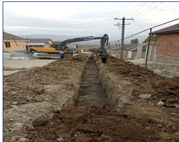
Строительство сетей водоснабжения с. Дылым Казбековского района 2023-2024
